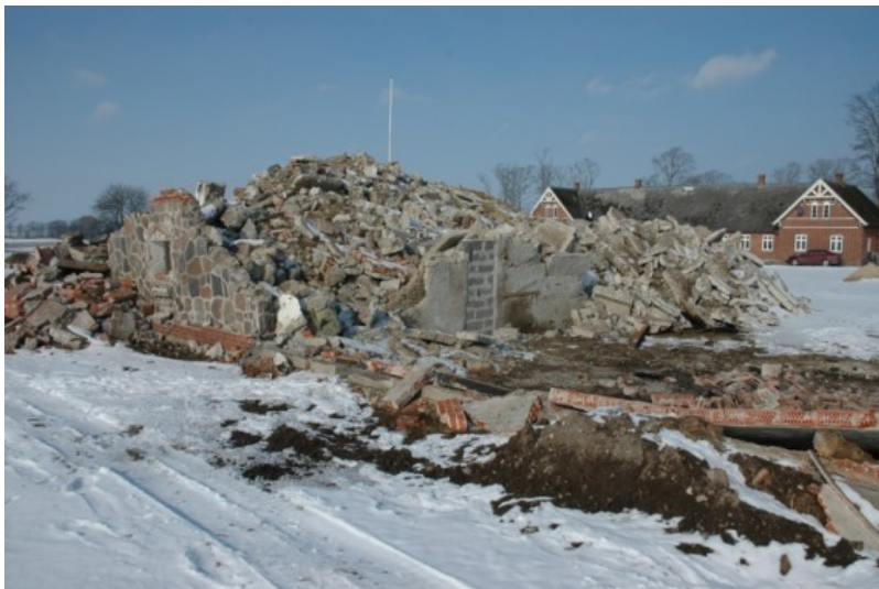
Sorteret byggeaffald, såsom beton og tegl inden knusning
